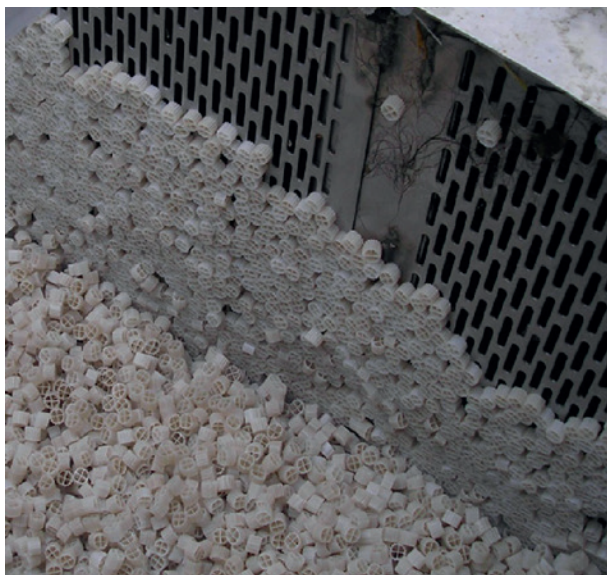
Ci-dessus : Grille plane partiellement colmatée © D.R.
