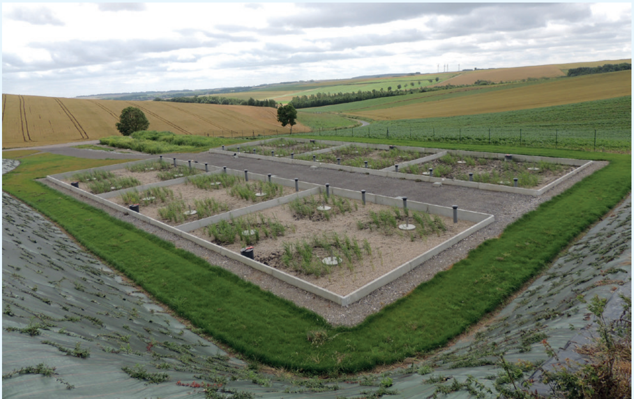
Ci-dessus : Station d'épuration par filtres plantés de roseaux à Dohem (62) © AEAP
