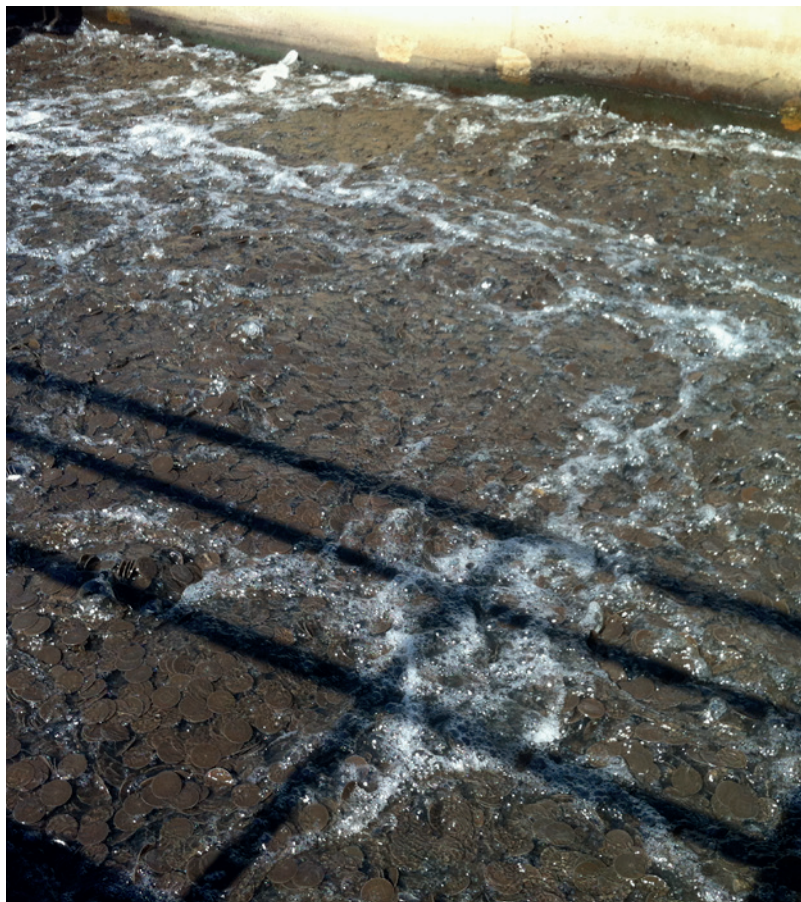
Ci-dessus : Réacteur à culture fixée fluidisée de la STEP de Saillon (Suisse) © Gaël Bost / Surfrider Léman
