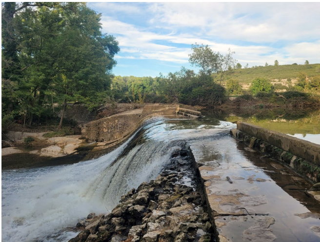
Seuil de Roquefavour © ARBE/L. Guermond
