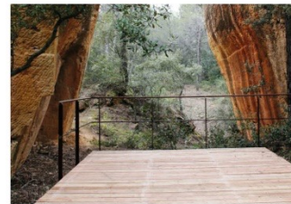
Main courante en ferronnerie et platelage bois marquant une placette d'observation - Site des carrières de Ebarnus - Aix-en-Provence (13) © Atelier Lieux Et Paysages
