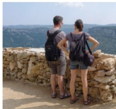
Garde-corps épais en maçonnerie de pierre Opération Grand Site de Navacelles Blandas (30) - © Atelier Lieux Et Paysages
