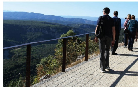
Garde-corps en ferronnerie avec barreaudages filants (câbles inox) Opération Grand Site de Vallon Pont d'Arc (07) - © CAUE 84
