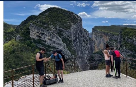
Garde-corps en ferronnerie avec barreaudages filants au Point Sublime Opération Grand Site des Gorges du Verdon - Rougon (04) © Atelier Lieux Et Paysages
