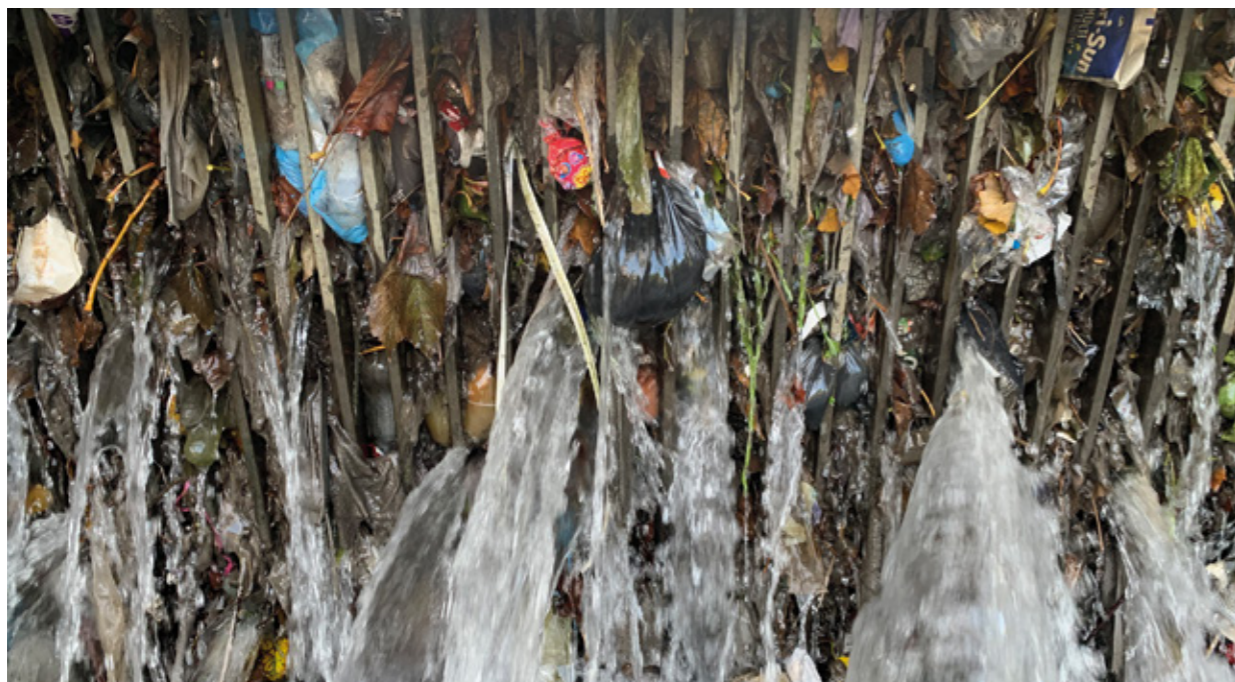
Limites d'efficacité des dégrilleurs métalliques
