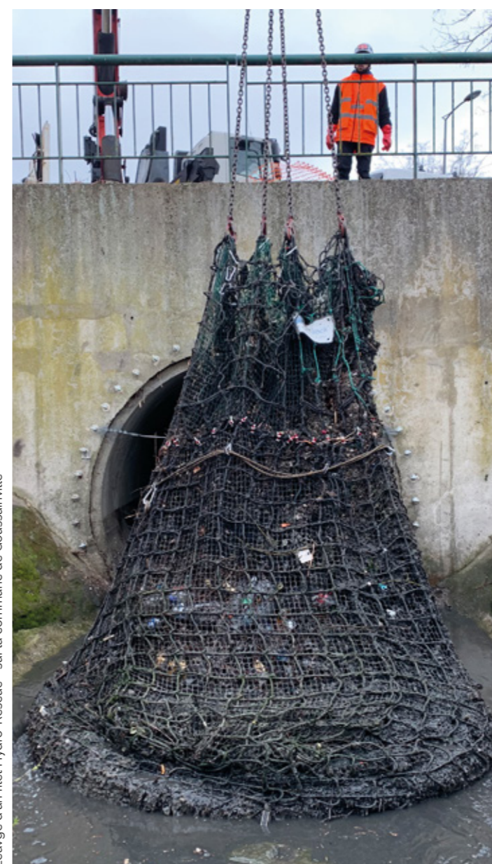
Leavage d'un filet Hydro-Rescue® sur la commune de Goussainville
