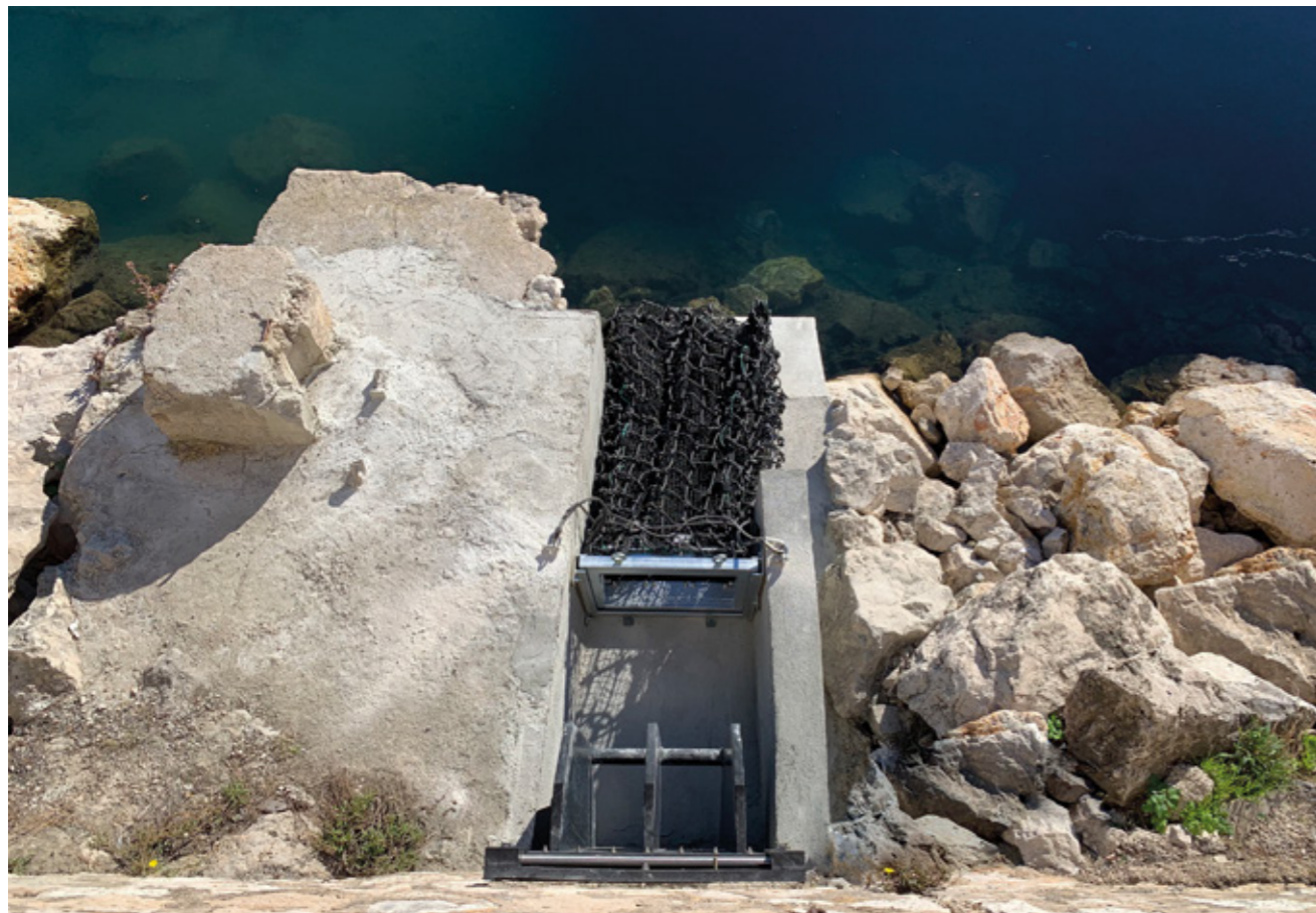
Filets anti déchets H-R installés sur la Principauté de Monaco.
