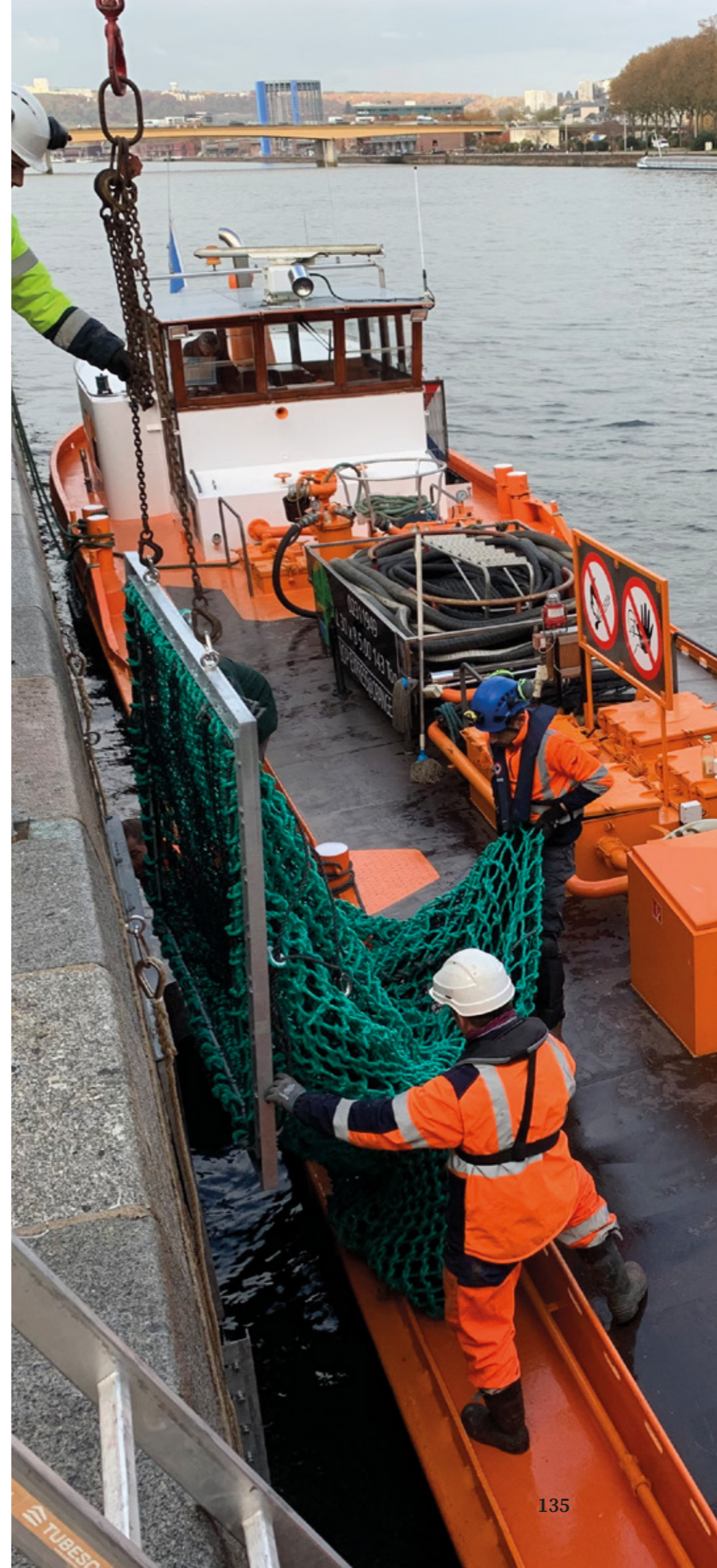
Mise en place d'un fillet sur cadre guillotine sur le quai de Seine
