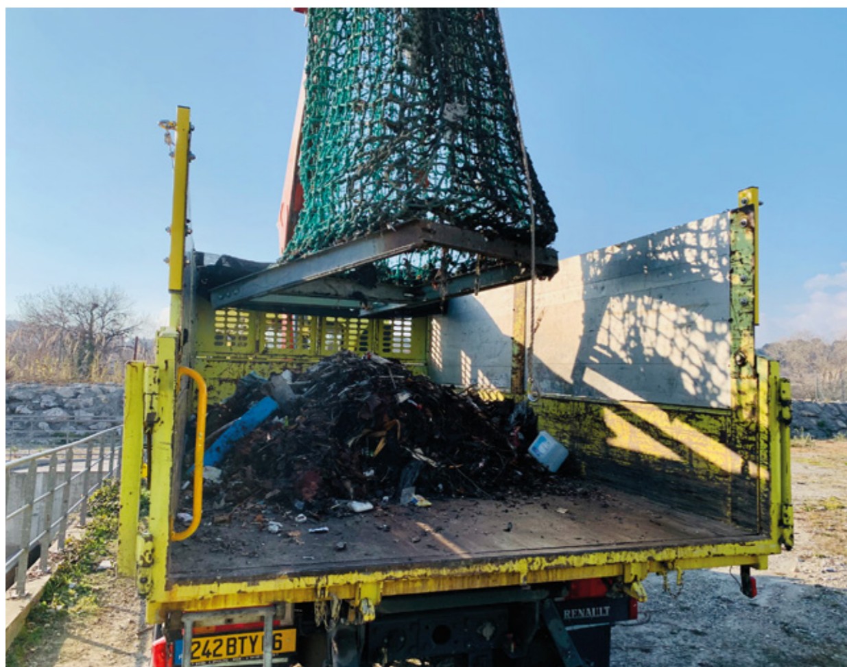
Grutage et vidage d'un filet Hydro-Rescue® sur le réseau Vinci Autoroutes
