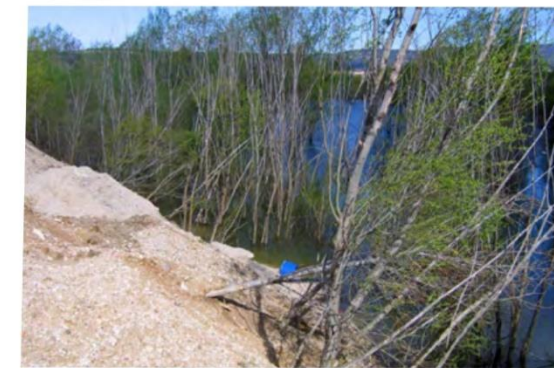
Remblaiement d'une mare ©PNRL
