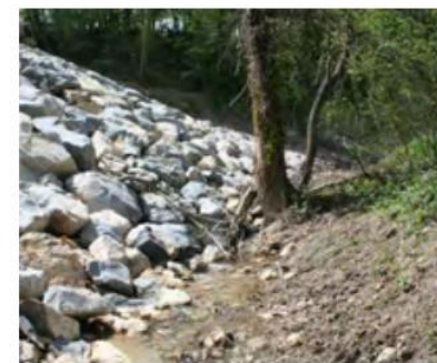
Enrochement de berge et de lit de rivière
