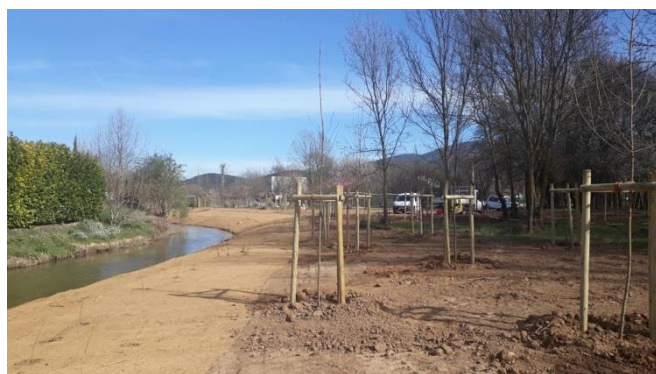
Plantations durant les travaux (février 2019) sur l'aval du projet, après abaissement de la rive gauche Source : SMBVH
