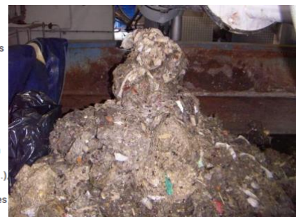
Exemple de refus de dégrillage en entrée de station d'épuration (Le Hyaric, 2009)
