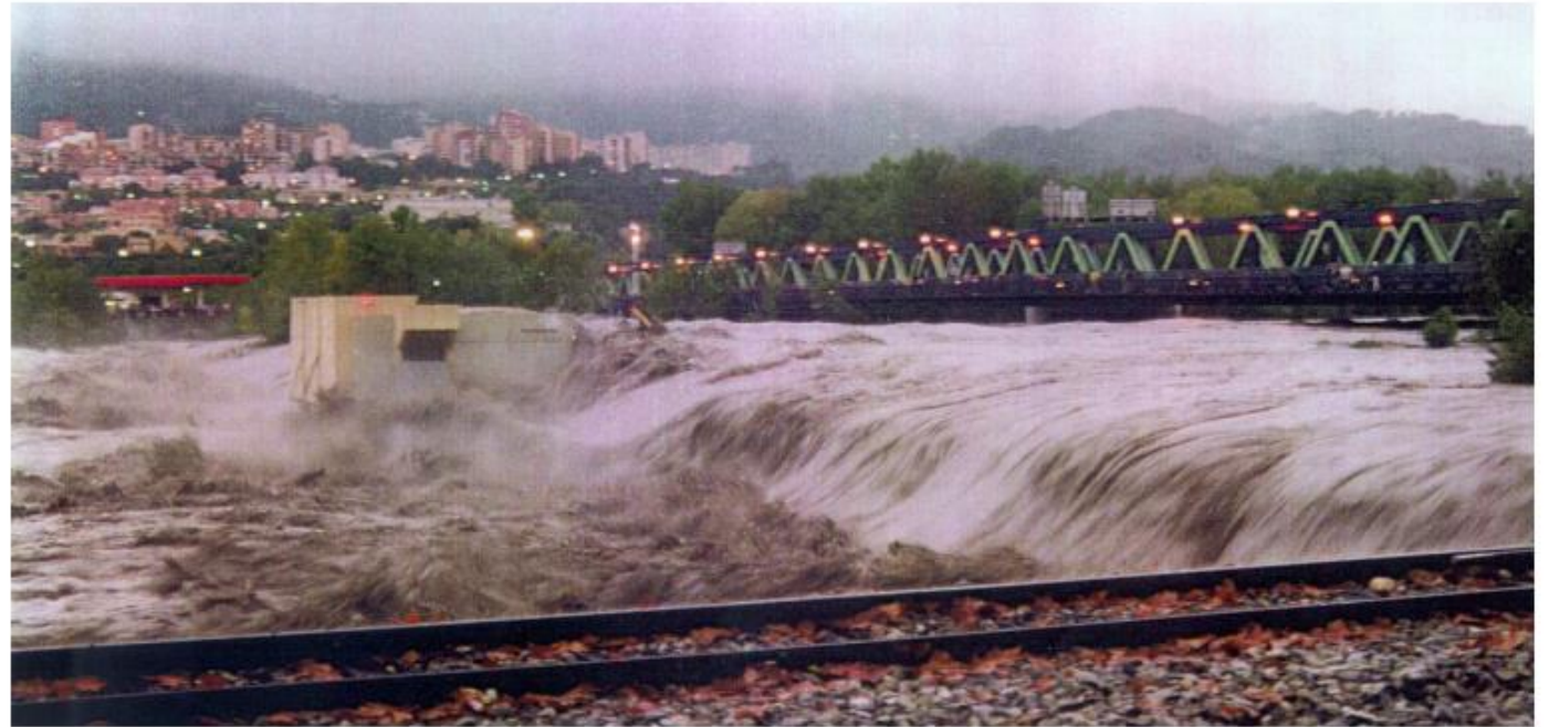
Seuil 7 pendant la crue de novembre 1994
