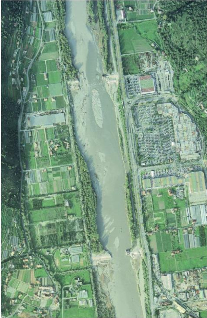
Rupture des seuils 2 et 3 (IGN, 12 novembre 1994)
