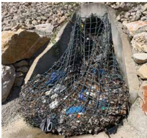
Piégeage des déchets par le filet
