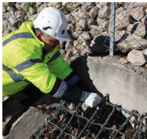
Détachement manuel du filet
