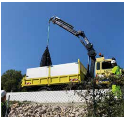
Vidage du filet par camion grue
