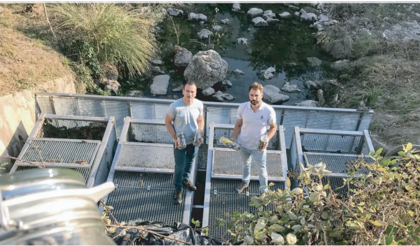
Les entrepreneurs dracénois ont installé, en contrebas de la voie Georges-Pompidou, quatre réceptacles destinés à stopper et retenir les déchets des eaux pluviales. **Photo CA.B.**
