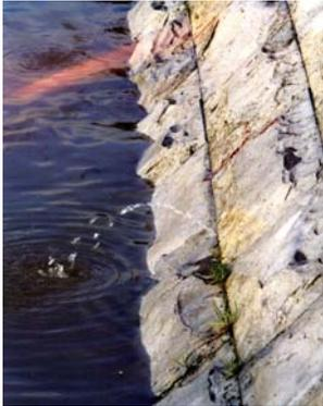
MUR DE QUIAI À LA DÉCRUE, AVEC JOINTS NON ÉTANCHES ET REMBLAI SATURÉ
