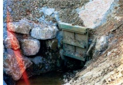
EXEMPLE D'UNE CANALISATION TRAVERSANTE AVEC VANNE
