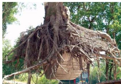
ENRACINEMENT TRÈS PUISSANT D'UN ARBRE DE 30 ANS SUR UNE DIGUE. CERTAINES RACINES TRAVERSENT LA DIGUE DE PART EN PART À PLUSIEURS MÈTRES DE PROFONDEUR.
