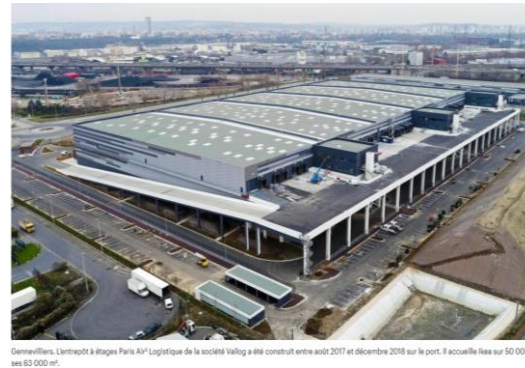
Gennevilliers, L'entrepôt à étages Paris A1 ® Logistique de la société Vallog a été construit entre août 2017 et décembre 2018 sur le port. Il accueille 150 sur 50 000 de ses 63 000 m 2 .
