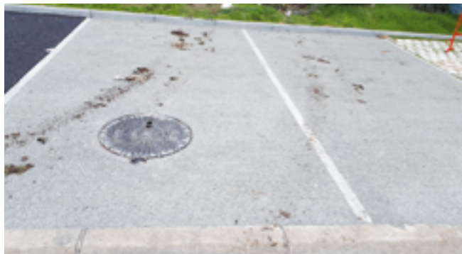
Exemple de risque de colmatage précoce dû au déplacement de remblais sur un revêtement perméable (© Wendy Arnould, Orléans)
