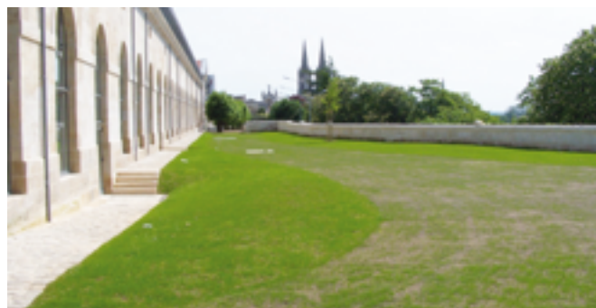
Remplissage de dalles alvéolées et végétalisation pour voie d'accès pompier (© Sylvie Pigot, Niort)
