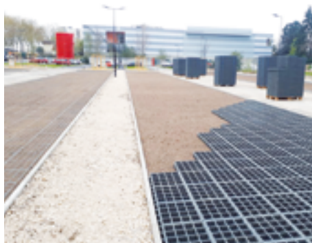
Pose de dalles alvéolées (© Wendy Arnould, Orléans)
