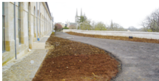
Remplissage de dalles alvéolées et végétalisation pour voie d'accès pompier (© Sylvie Pigot, Niort)
