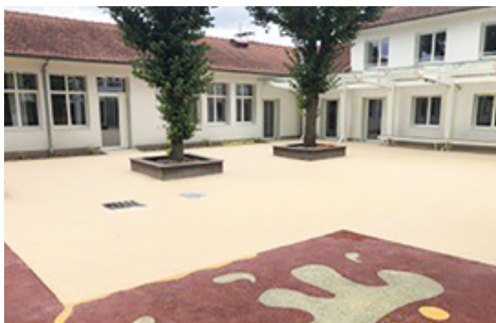
Utilisation d'un béton de résine dans une cours d'école (© Anthélys – Meudon)
