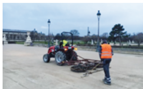
Ratissage d'un stabilisé - Parc des Tuileries (© DPAJ SDJ EPML Louvre)
