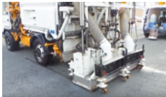
Décolmatage par pression/aspiration (© Sotraveer)
