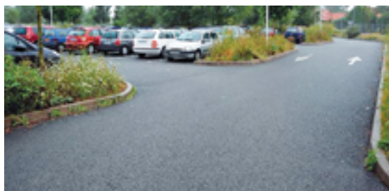
Enrobé poreux sur structure réservoir (© Lille Métropole)
