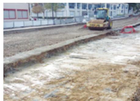
Exemple de terrassement d'une zone accueillant un revêtement perméable (© P&C – Robin Dagois)
