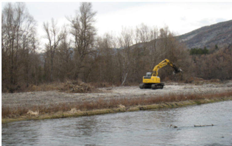
Banc en cours d'essartement. Les arbustes sont arrachés et regroupés avant évacuation. (©Boyer M./Aquadbio)
