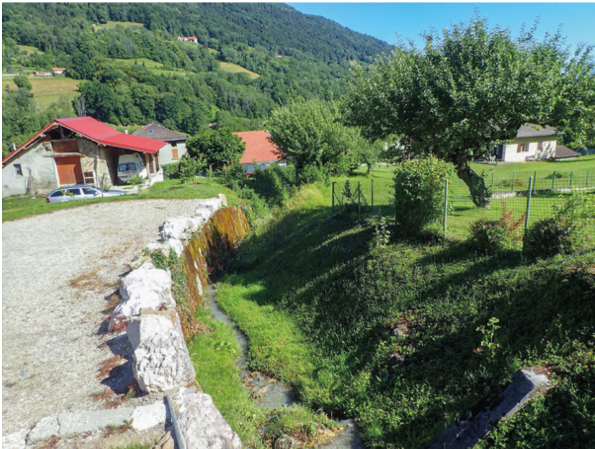
Exemple de cours d'eau canalisé sur son cône de déjection. Le moindre débordement peut impacter de nombreuses habitations situées en contrebas. Le lit doit donc être débroussaillé tous les ans pour réduire les hauteurs d'eau en crue. (©Boyer M./Aquabio)
