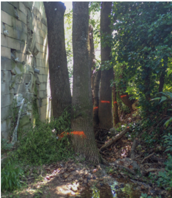
Arbres adultes ayant poussé dans un très petit cours d'eau canalisé et présentant des assecs prononcés : ils doivent être abattus pour retrouver le gabarit initial du lit permettant l'écoulement des crues. (©Boyer M./Aquabio)
