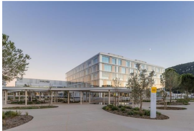
Bâtiment fonction support
