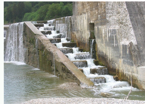
↑ infrastructures en béton
