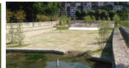
Bassin d'infiltration paysager (pluie annuelle)
