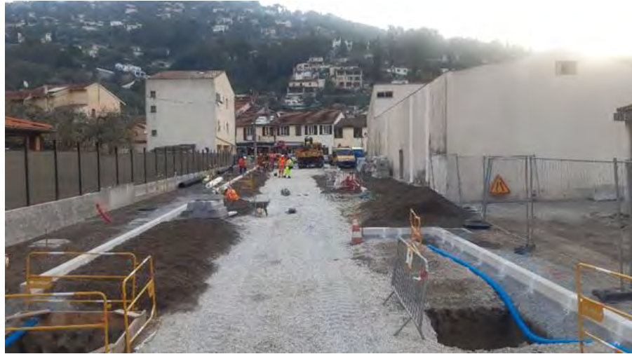
Préparation avant la mise en œuvre des enrobés
