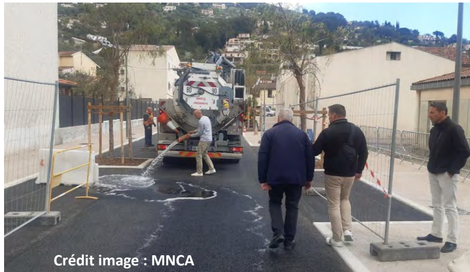
Application puis test de l'enrobé drainant BBDr
