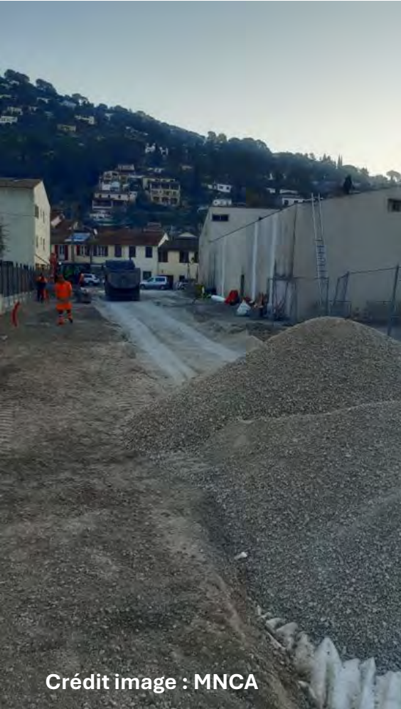
Mise en place de la couche de grave drainante sur 0.34m d'épaisseur
