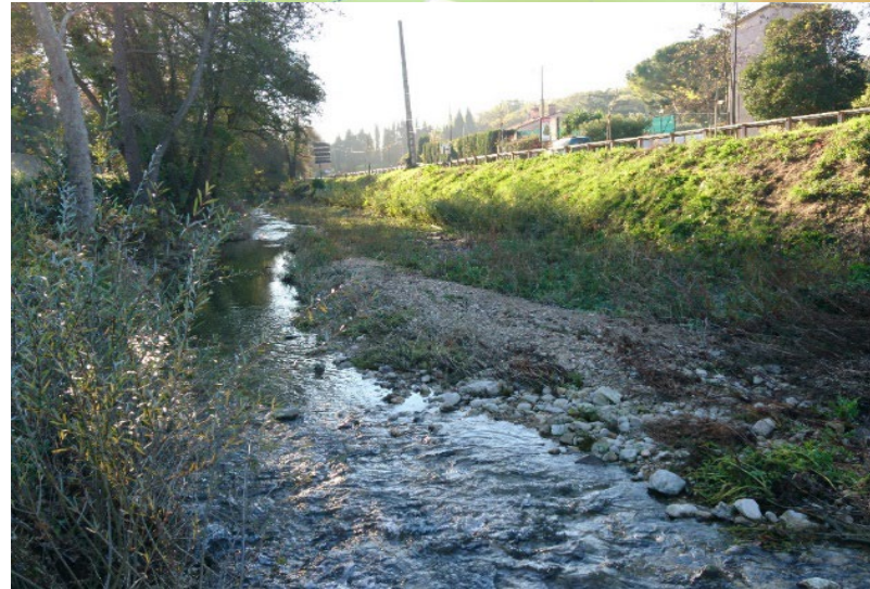
Etat post travaux
