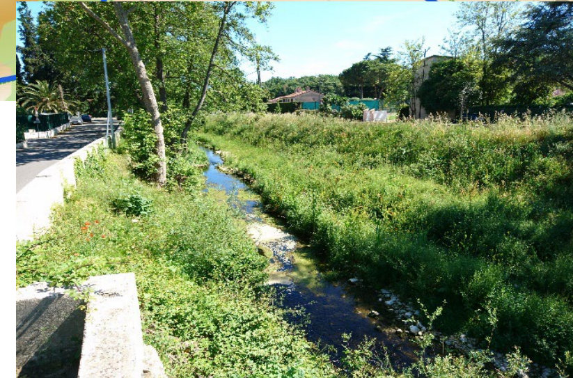
Aménagement à N+1
