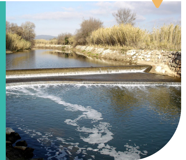
Barrage anti-sel du Gapeau © Maison Régionale de l'Eau
