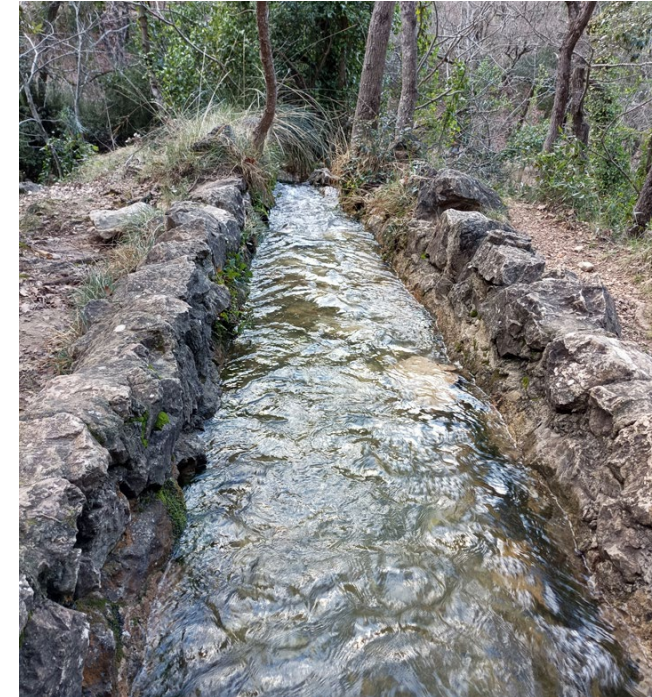
Canal d'irrigation, le Vède sur la commune d'Auriol © ARBE/C. Roehilly
