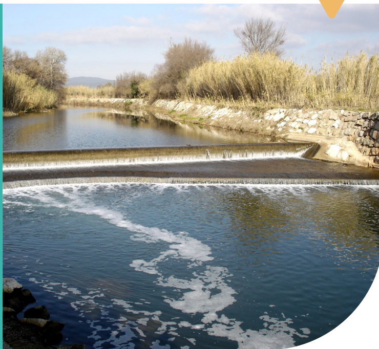
► Barrage anti-sel du Gapeau © Maison Régionale de l'Eau
