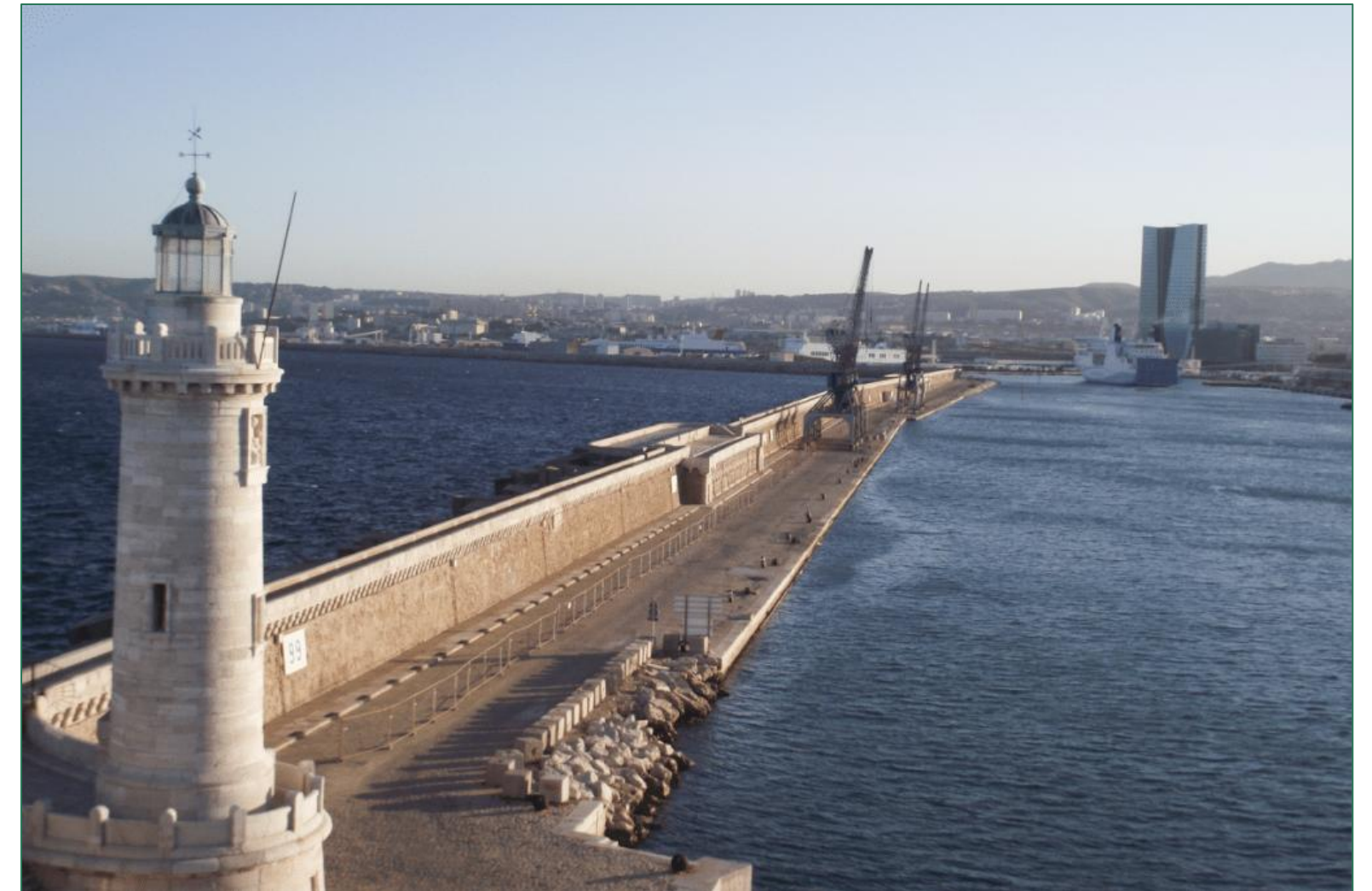
Digue du large de Marseille @Fotocommunity
