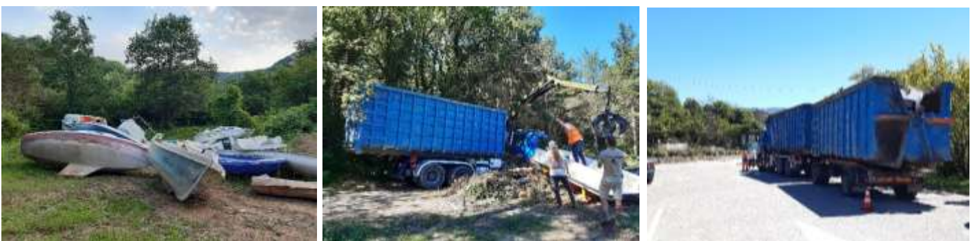
5- Enlèvement des épaves par l'entreprise SCLAVO Environnement
