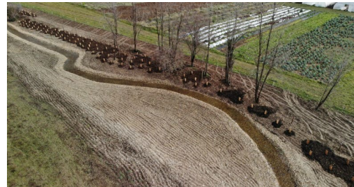
Fin du chantier de restauration du Colostre en amont d'Allemagne-en-Provence ©Riparia
