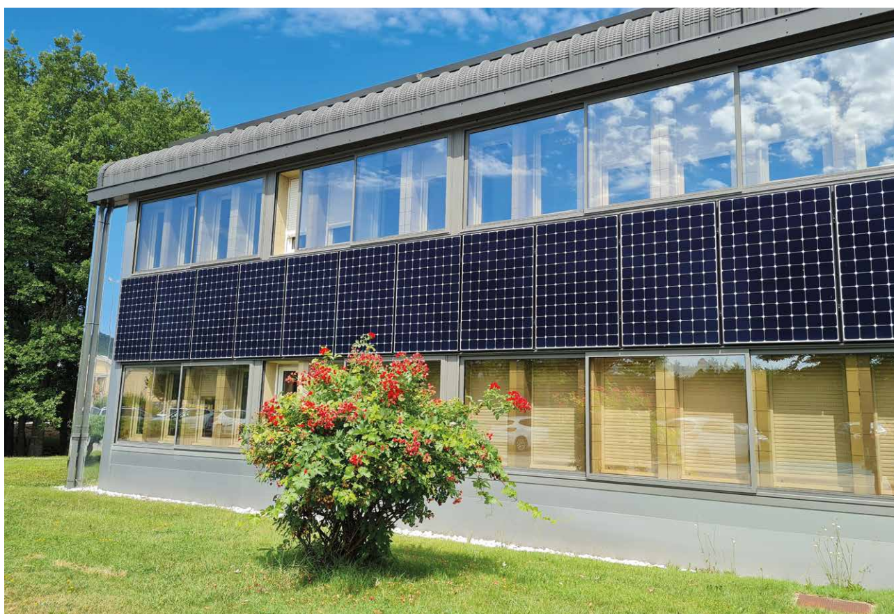
Réhabilitation d'un bâtiment existant avec intégration de panneaux photovoltaïques en façade. Parc d'activités Val de Durance, Sisteron (04). © ARBE.
