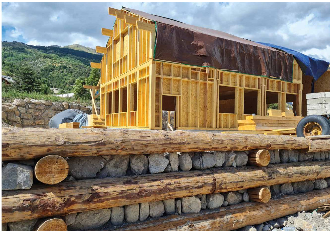
Construction neuve en ossature bois. Parc d'activités du Villaret, Saint-Martin-de-Queyrières (05). © ARBE.
