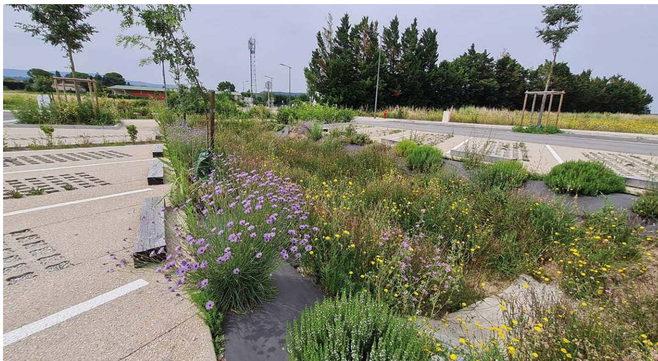
Création d'une noue infiltrante plantée d'espèces méditerranéennes et parking perméable. Parc d'activités Piol 2, Mazan (84). © ARBE.
