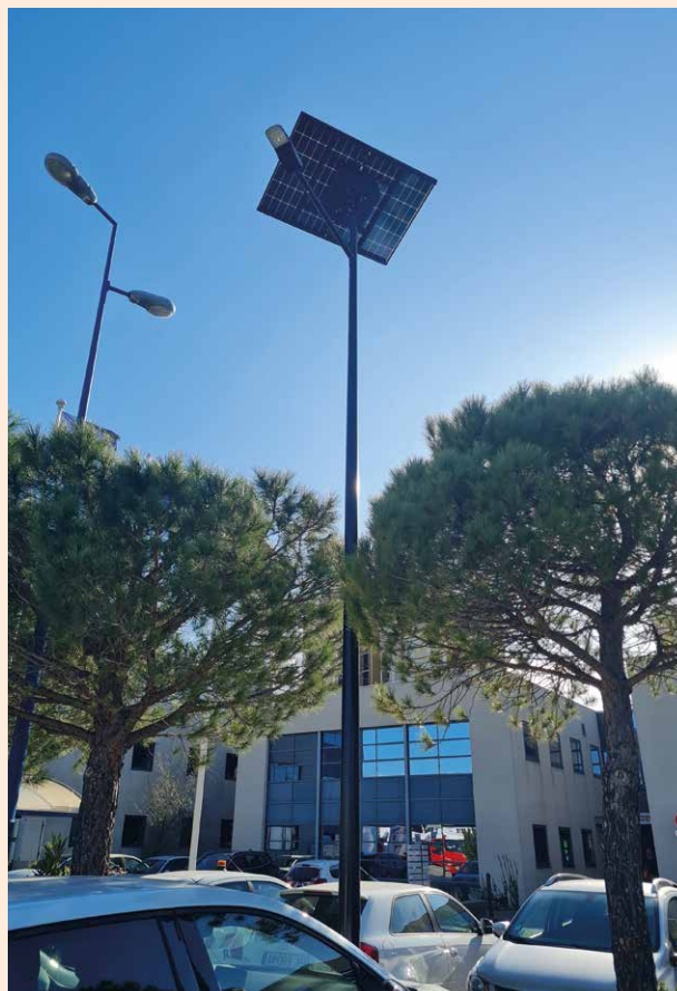
Changement de luminaires vers des led solaires et réduction du nombre de points lumineux sur le MIN d'Avignon (84). © ARBE.
