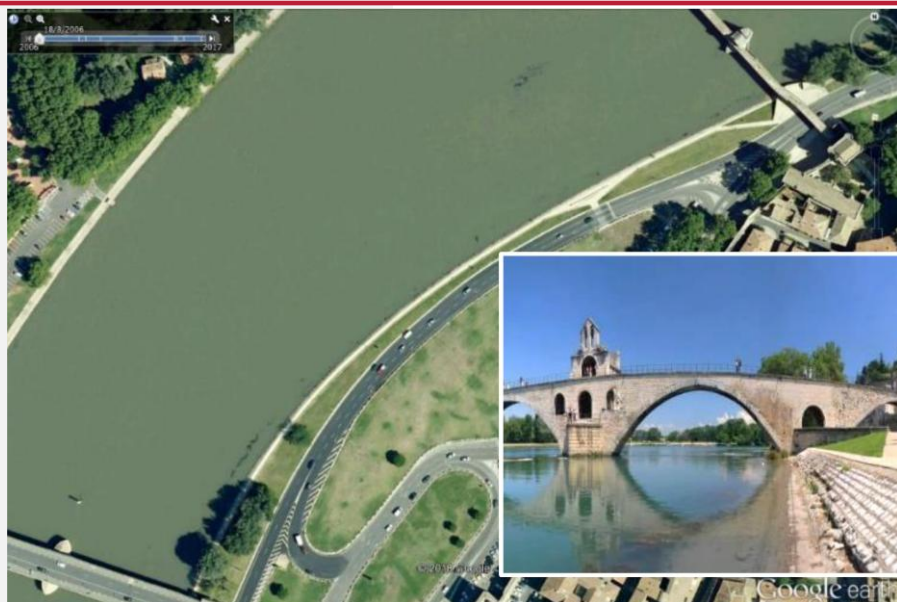
Situation en 2006 : perré dépourvu de végétation
