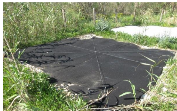
Géotextile synthétique renforcé avec feuille de cuivre ROOTX (170 g/m 2 )
