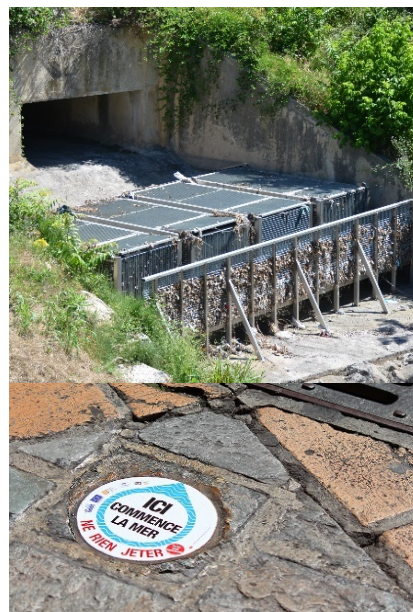
En haut : système de filtration en sortie d'exutoire d'eau pluviale (Draguignan)
