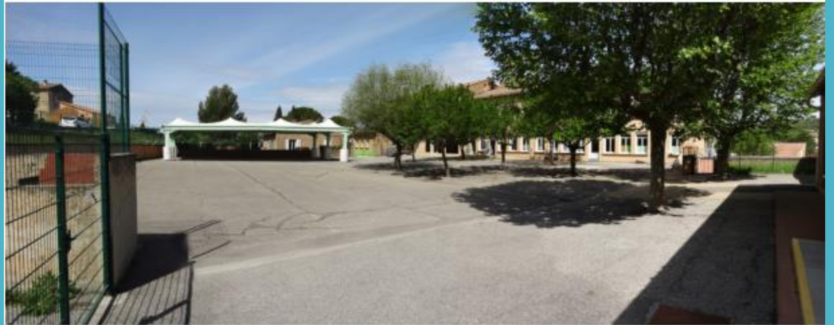
Ecole primaire Les Ogres, état actuel
