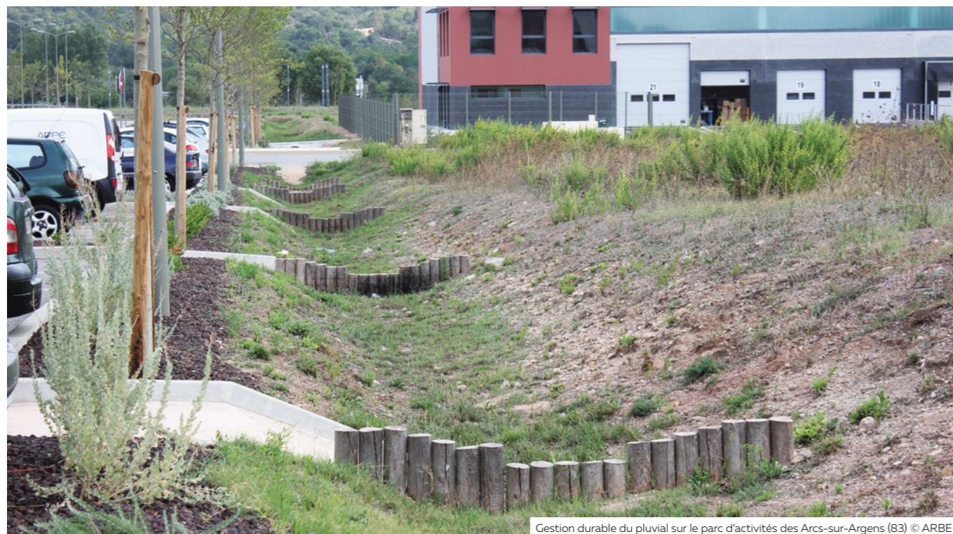
Gestion durable du pluvial sur le parc d'activités des Arcs-sur-Argens (83) © ARBE
