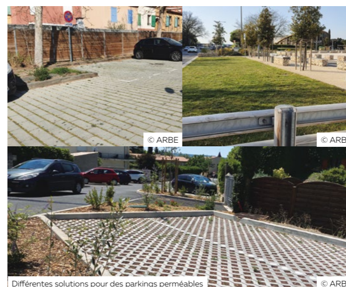
Différentes solutions pour des parkings perméables © ARBE
