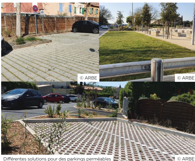
Différentes solutions pour des parkings perméables
