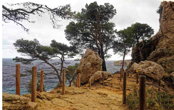
Réalisation d'embranchements à Port Pin ; Poteaux-fils à Sugiton
