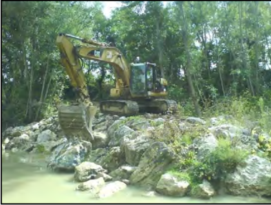
Renforcement de l'épi déflecteur
