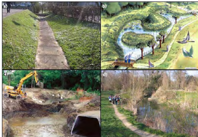
Bétonnée à Fresne, la Bièvre a été remise à ciel ouvert sur 200 mètres. Pour cette opération « vitrine » dans le Val-de-Marne, le coût du mètre de restauration avoisine les 2 000€.
