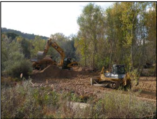
Essartement et arasement du banc amont
