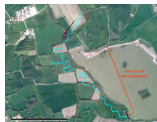
Projet « Abeille » : restauration d'une rivière souterraine sur le site d'une gravière.
