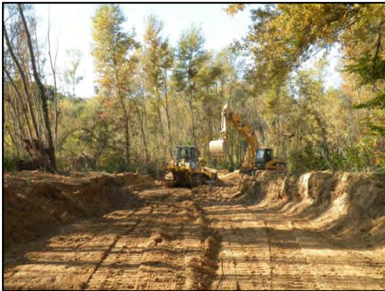
Restauration / création du chenal de crue principal
