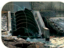
Vis d'Archimède très peu de dommages sur smolts et anguilles 1 à 10 m de chute Q = 0,5 à 5 m 3 /s
