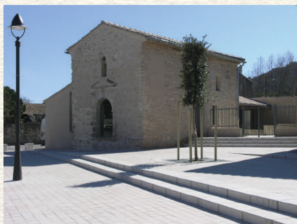
Revêtements de sol en pavage calcaire à Robion
