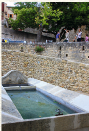
Ancien lavoir d'Aurel
