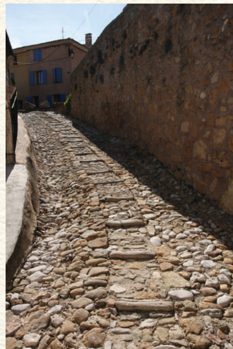
Ancienne calade restaurée à Bédoin
