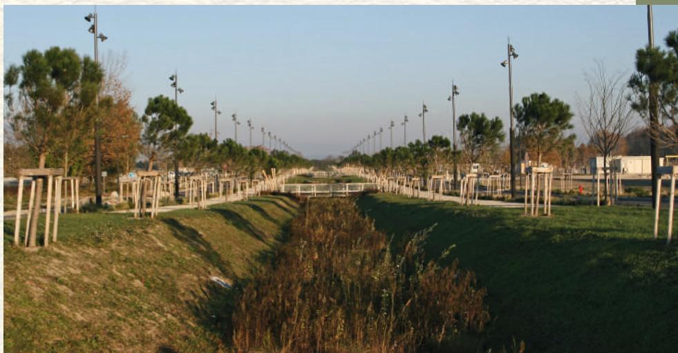
Bassin de rétention de la zac de Beaulieu à Montoux
