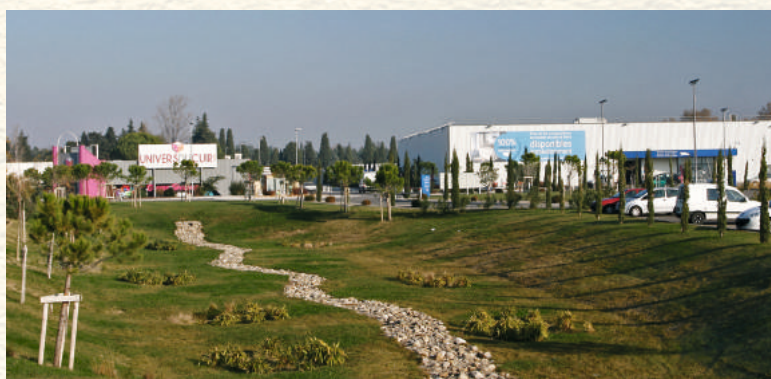
Bassin de rétention en zone commerciale d'Avignon
