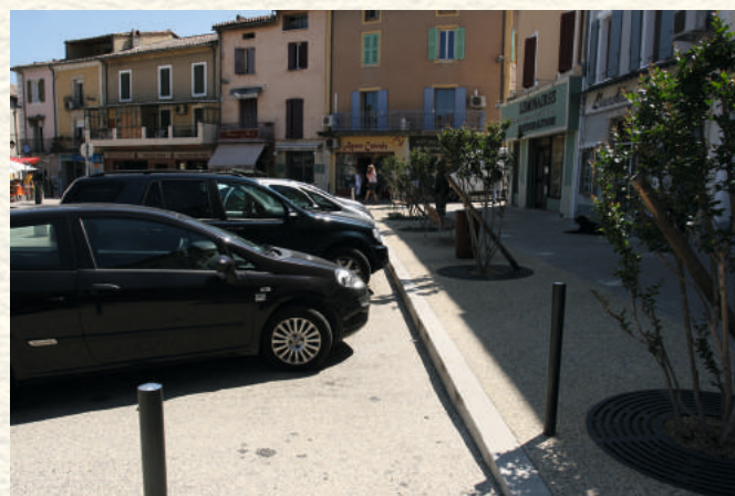
Réorganisation du stationnement et des espaces piétons sur la place Montfort à Vaison-la-Romaine
