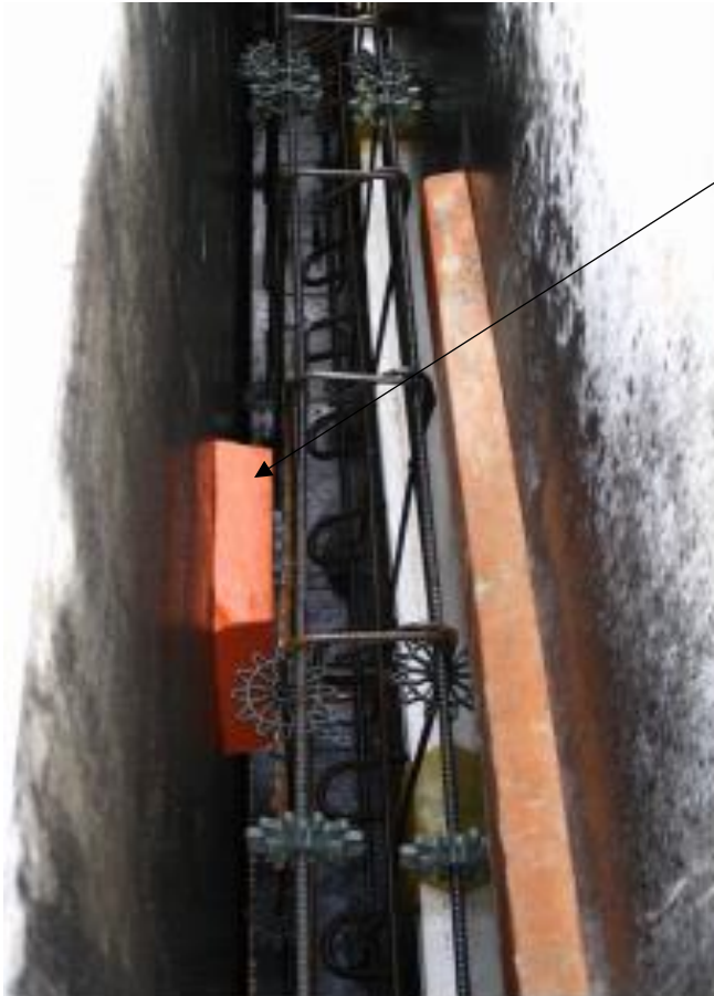
Installation de gabarits de réserve
