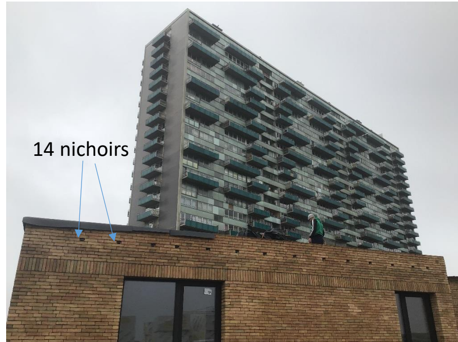
Façade après travaux
